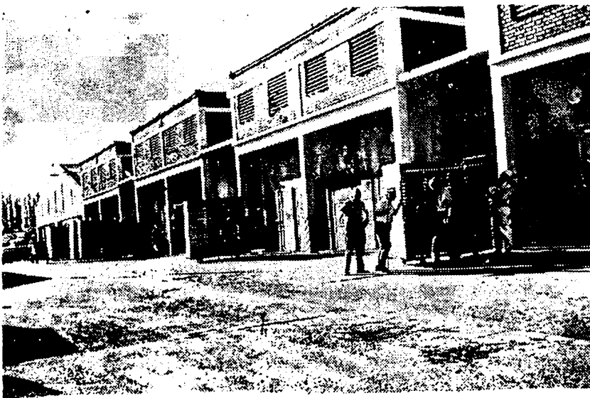
Fot. 30 — Secaderos modernos de la CAP. Algunos de los 20 hornos que posee esta fábrica. Se extiende la fruta en unos zarzos escalonados entre los cuales circula el aire caliente y seco.
