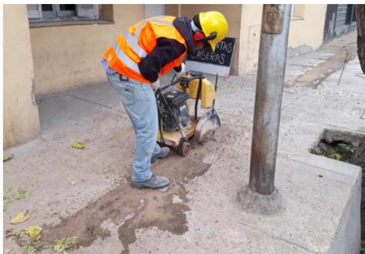
Figura 29. Aserrado de contrapiso de vereda
