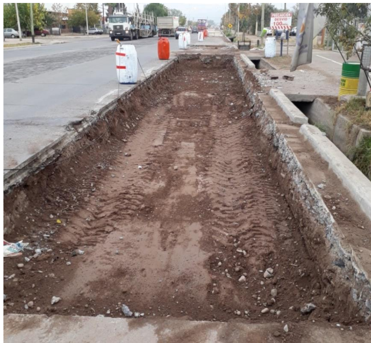
Figura 18. Superficie preparada para recibir el rechazo de cantera
