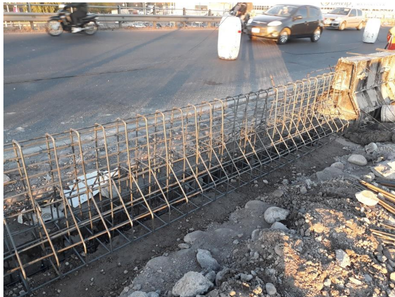
Figura 12. Armadura de New Jersey colocada
