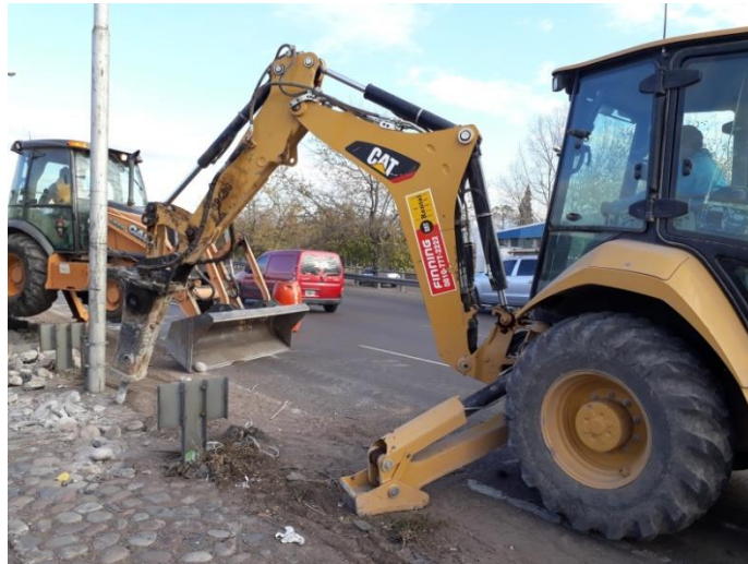
Figura 9. Picado de empedrado
