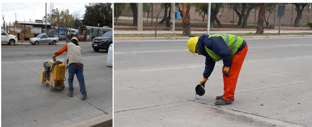
Figura 8. Limpieza y resellado de juntas de contracción
