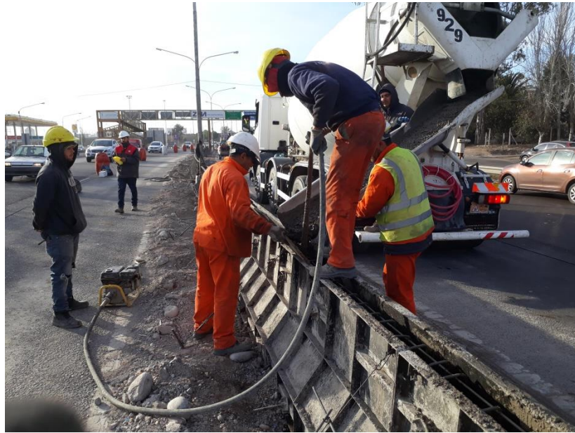
Figura 13. Colado y vibrado de hormigón H21 para New Jersey
