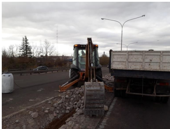
Figura 10. Retiro de escombros
