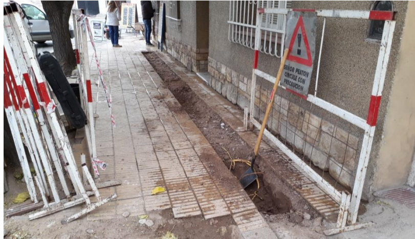
Figura 30. Zanja en vereda cubierta luego de colocar el cableado
