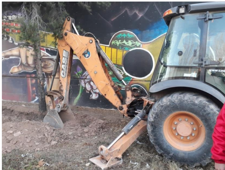
Figura 26. Excavación de zanja con retroexcavadora en una lateral de Av. Costanera
