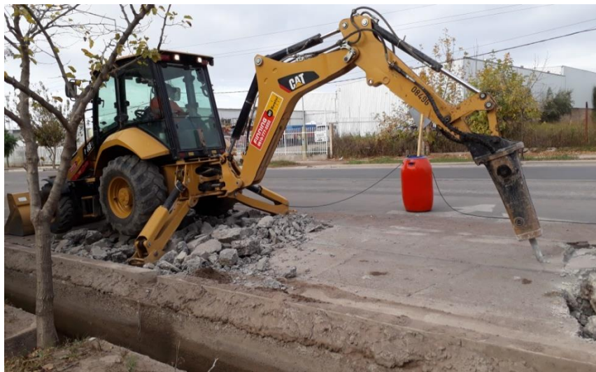
Figura 17. Demolición de losas dañadas
