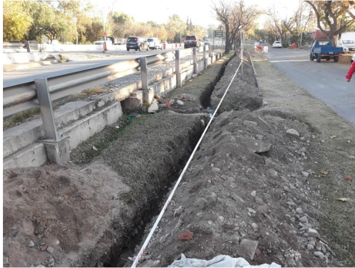
Figura 25. Zanja excavada manualmente en una lateral de Av. Costanera
