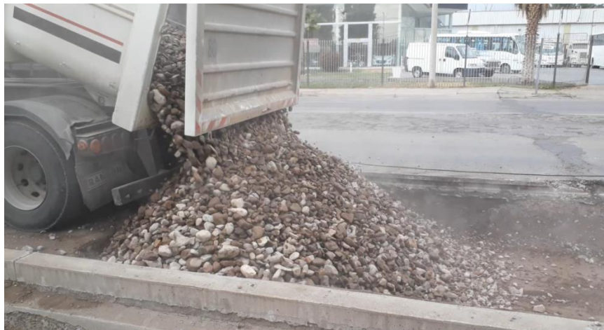
Figura 19. Descarga de rechazo de cantera
