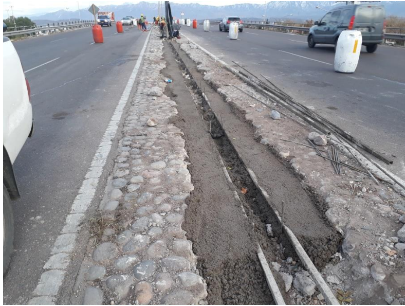
Figura 11. Hormigón de limpieza en la base de barrera "New Jersey"
