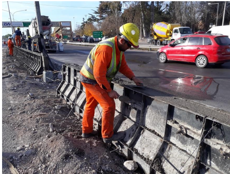
Figura 14. Llaneado final de la cara descubierta del New Jersey
