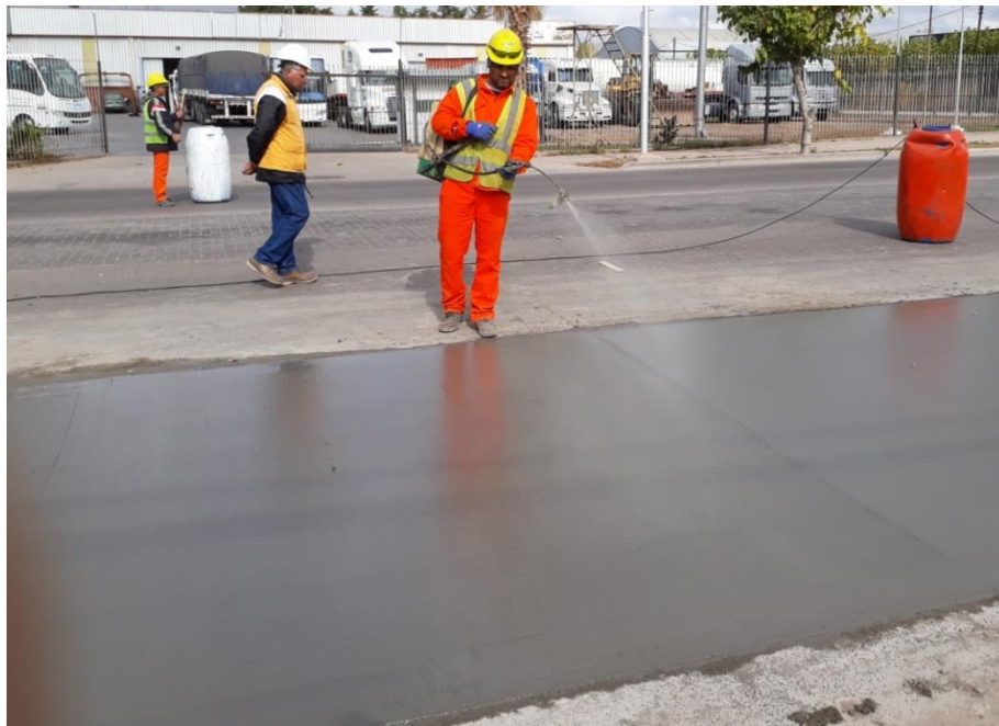
Figura 23. Aplicación de "anti-sol"
