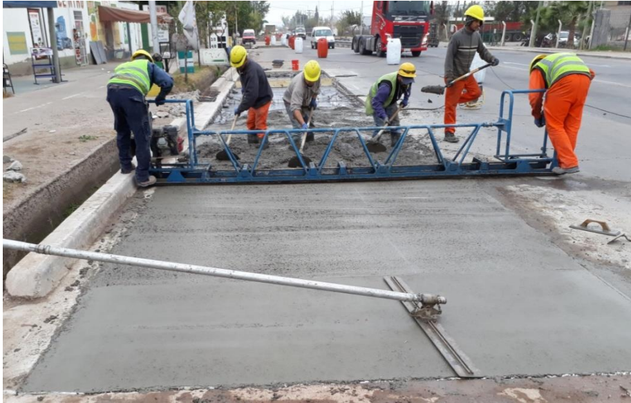
Figura 22. Regleado con regla vibratoria y alisado con fratacho de aluminio
