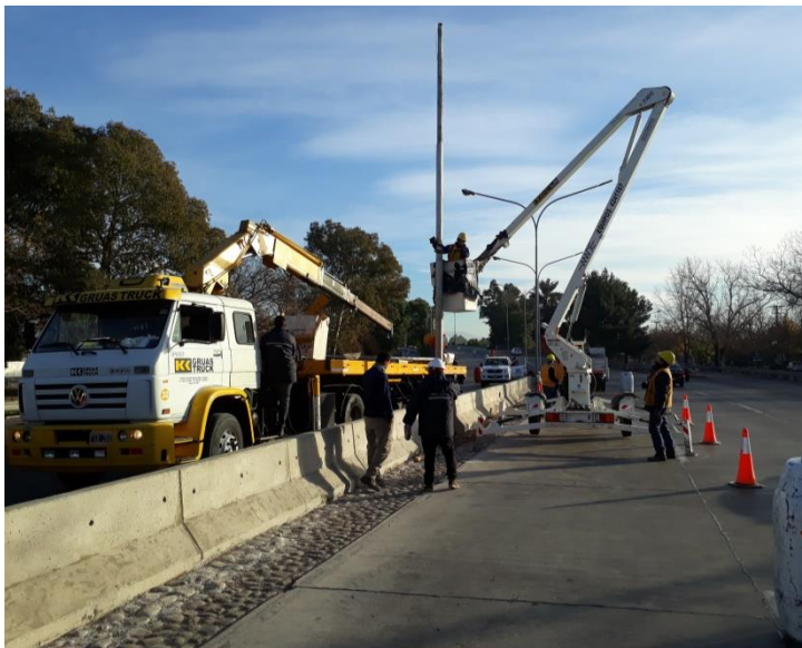
Figura 31. Grúa y elevador hidráulico utilizados para remover columnas de iluminación dañadas
