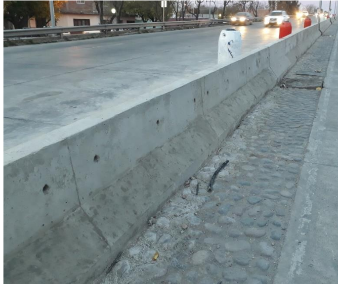
Figura 15. Barrera New Jersey terminada
