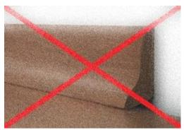
Llaneados, cerámicos sin grietas, de fácil limpieza y desinfección. El ángulo de unión piso pared en lo posible debe ser de cuarto caña. Hay que evitar zócalos de madera.
